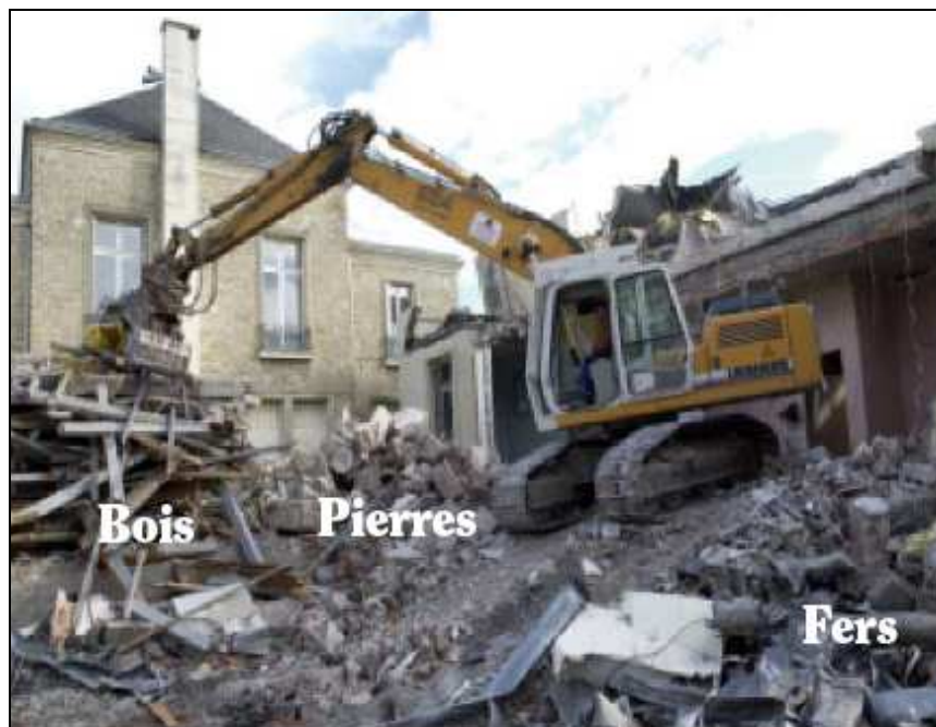
Illustration 82 : Chantier de la mairie des Mureaux, pré-tri des déchets.
