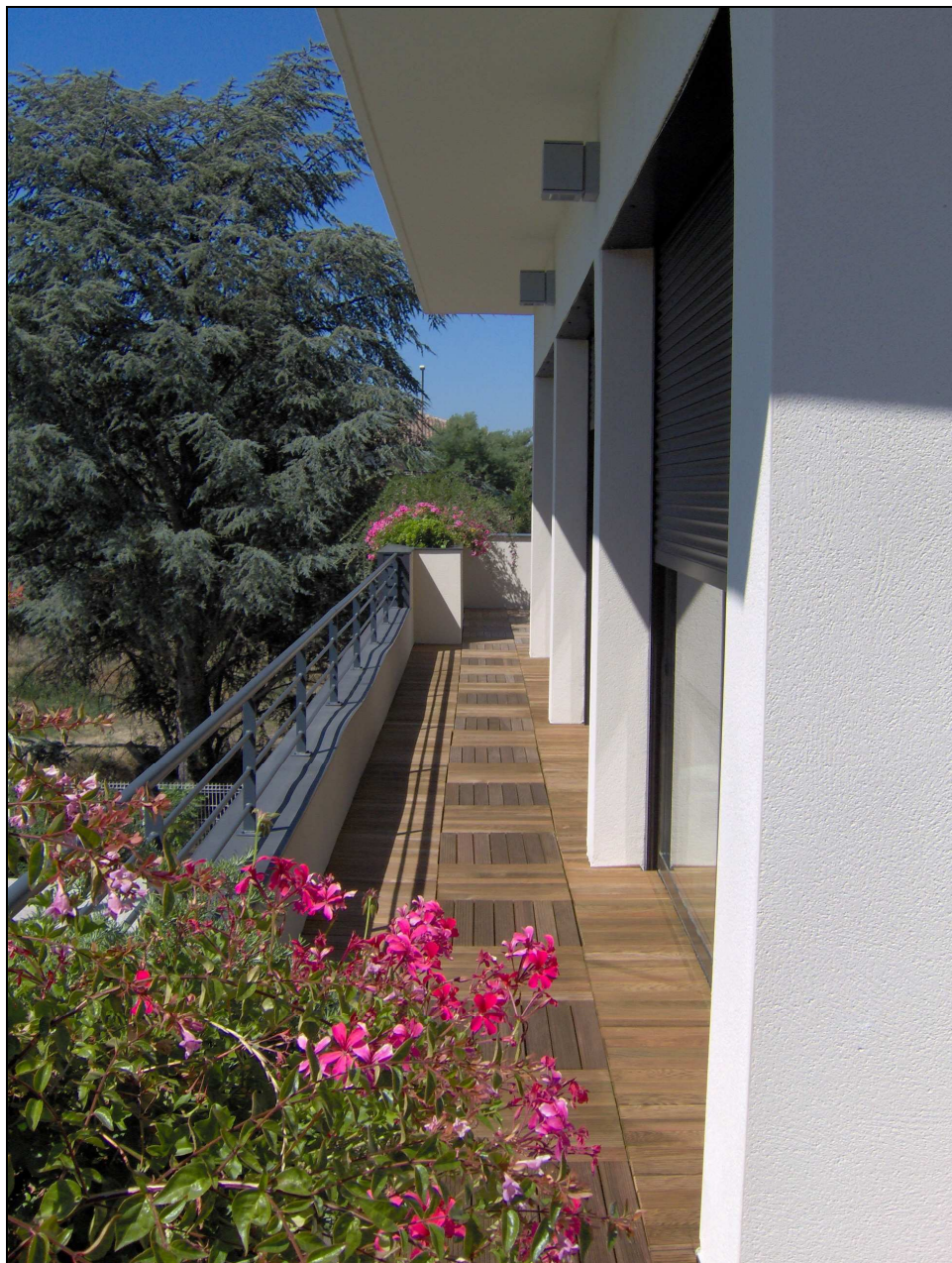
Illustration 134 : Maison Jullien, coursive premier étage sur jardin.
