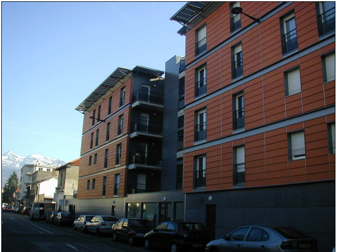
Illustration 115 : Immeuble 31-33 rue Moyrand, façade nord, sur rue.
