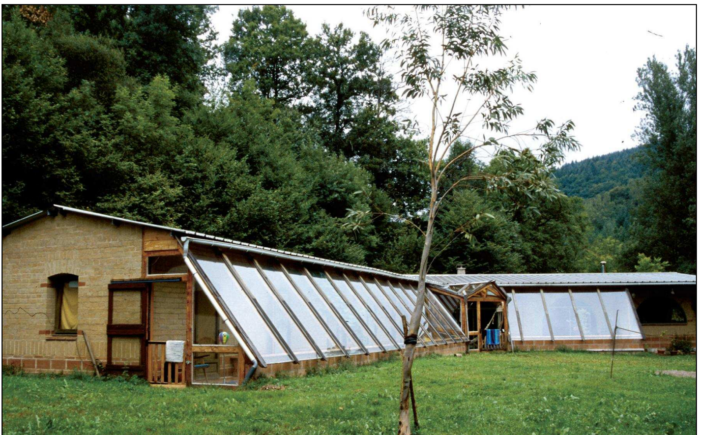
Illustration 168 : Moulin de la Resse, façade sud-ouest.
