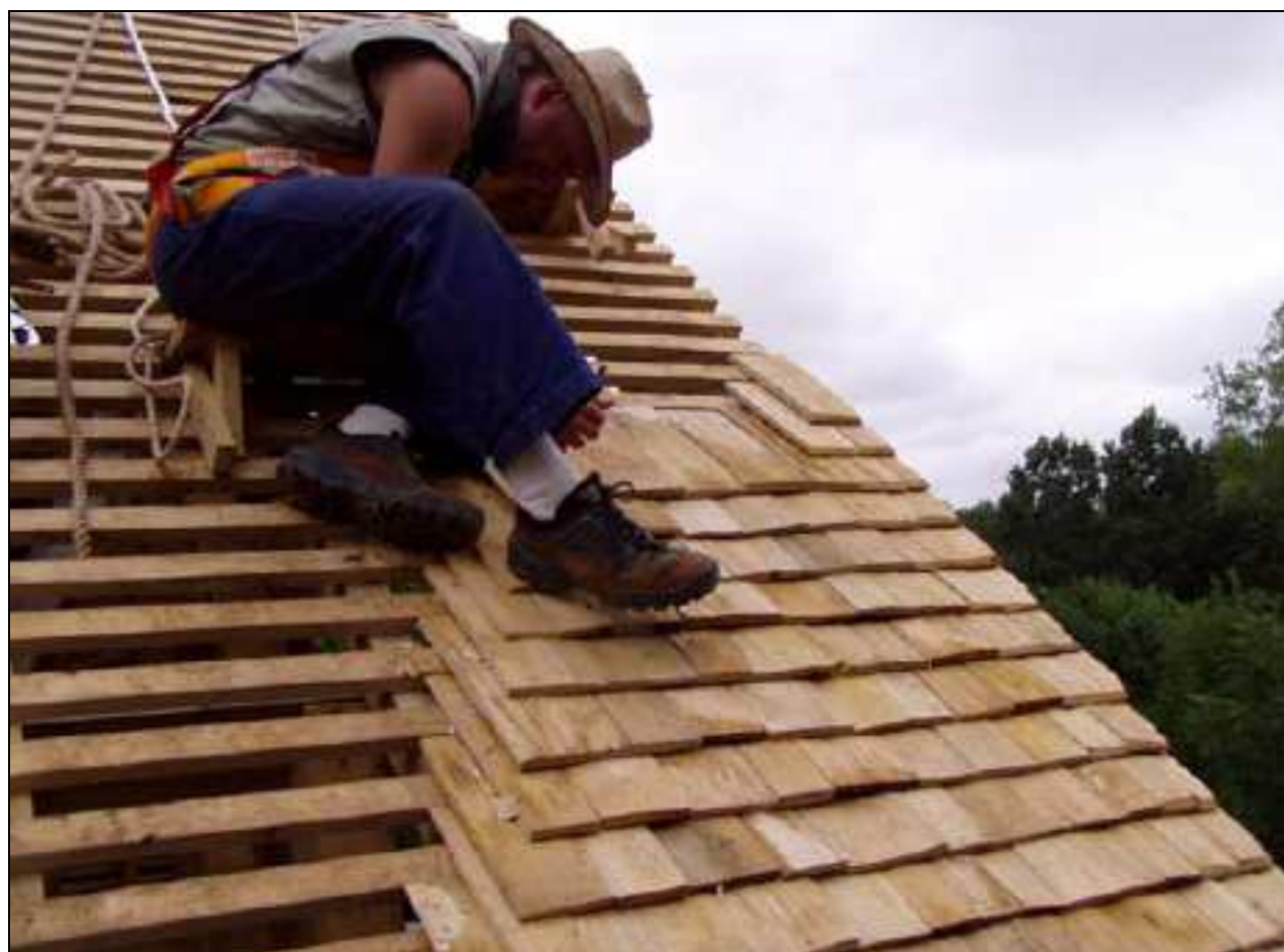
Illustration 158 : Salle de réunion du plan d'eau du Lambon, pose des bardeaux de toiture.
