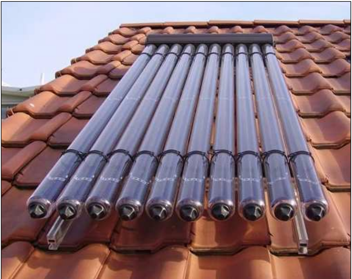
Illustration 87 : Capteur solaire à tube.
