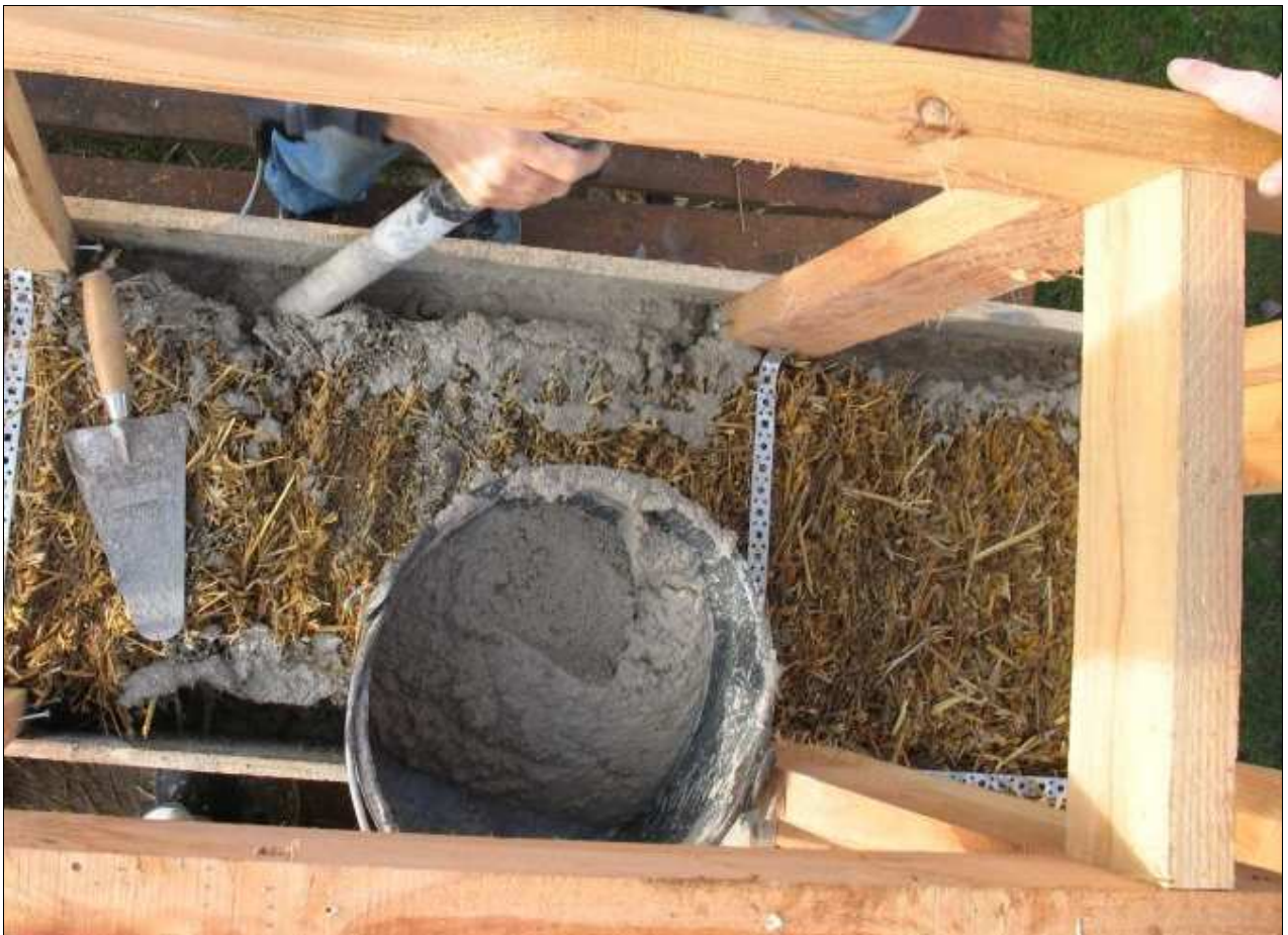
Illustration 154 : Technique du G.R.E.B., banchage et coulage de l'enduit.
