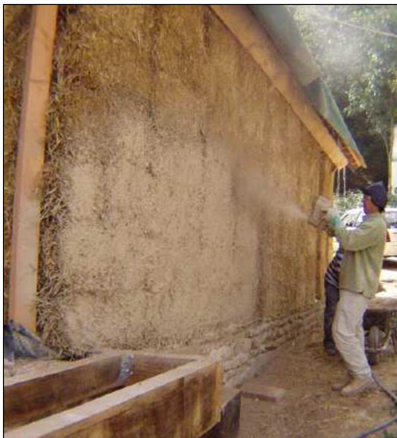
Illustration 162 : Salle de réunion du plan d'eau du Lambon, première couche d'enduit au ciment-gun
