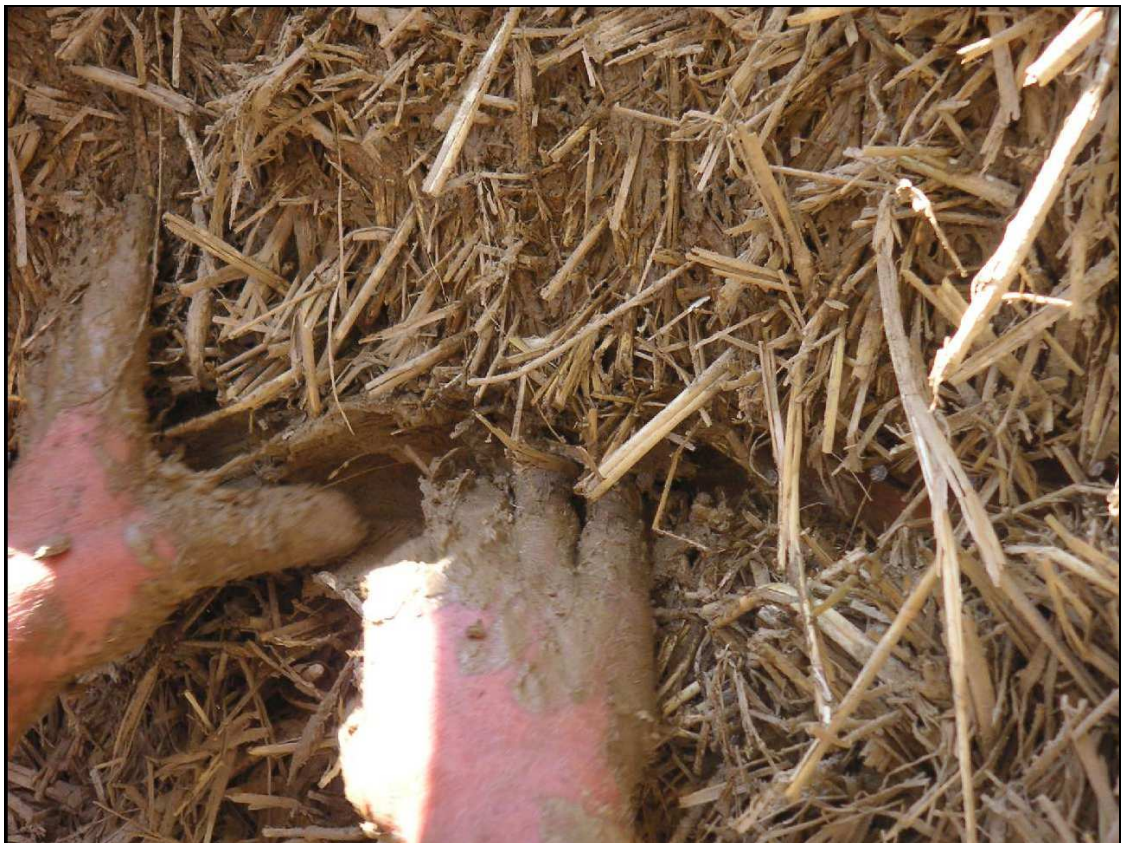
Illustration 166 : Traitement des éventuels ponts thermiques.
