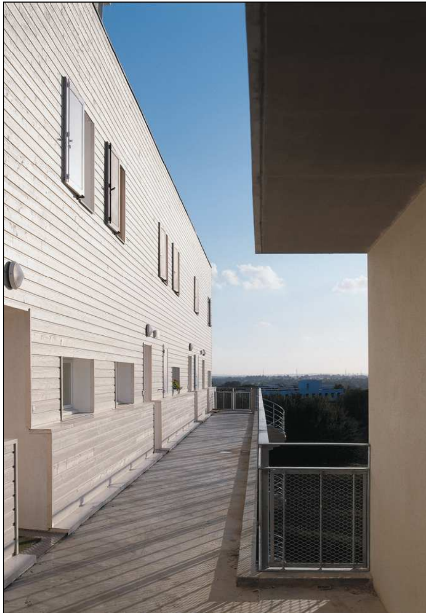
Illustration 124 : Résidence Salvatierra, coursive supérieure, façade nord.
