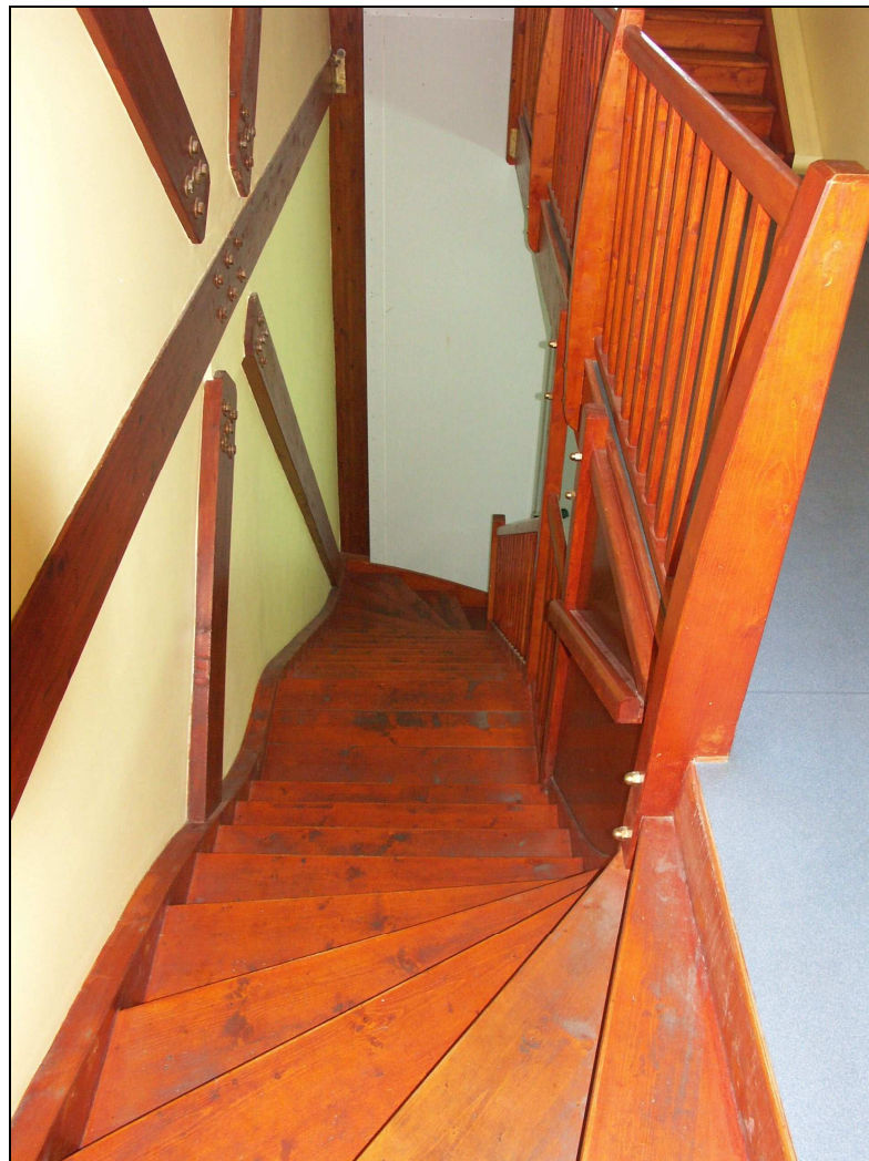
Illustration 108 : Chambre froide Hippocampe caraïbe, escalier d'accès aux bureaux et aux locaux du personnel.
