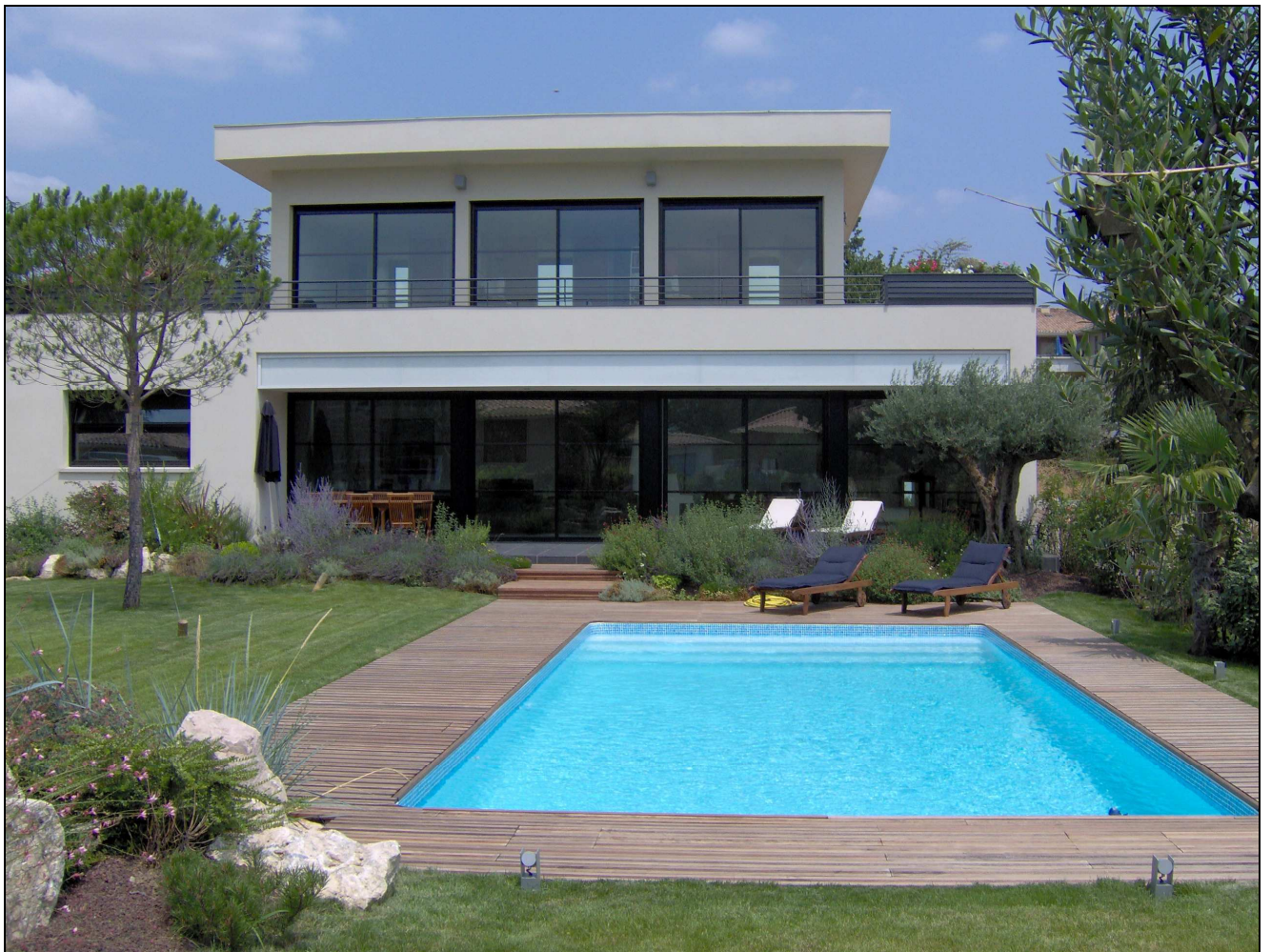
Illustration 132 : Maison Jullien, façade sur jardin.
