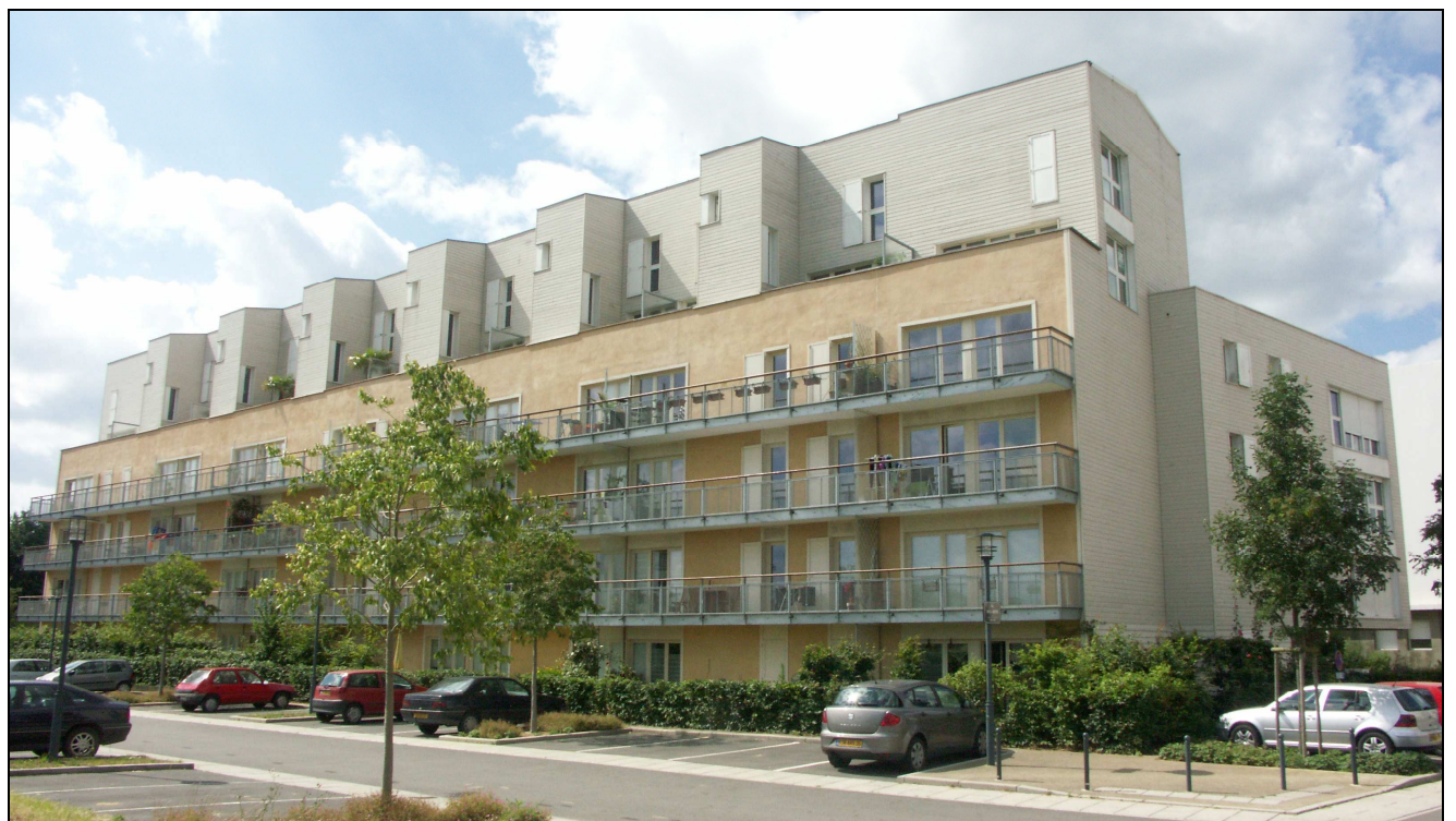
Illustration 120 : Résidence Salvatierra, vue sud-ouest.
