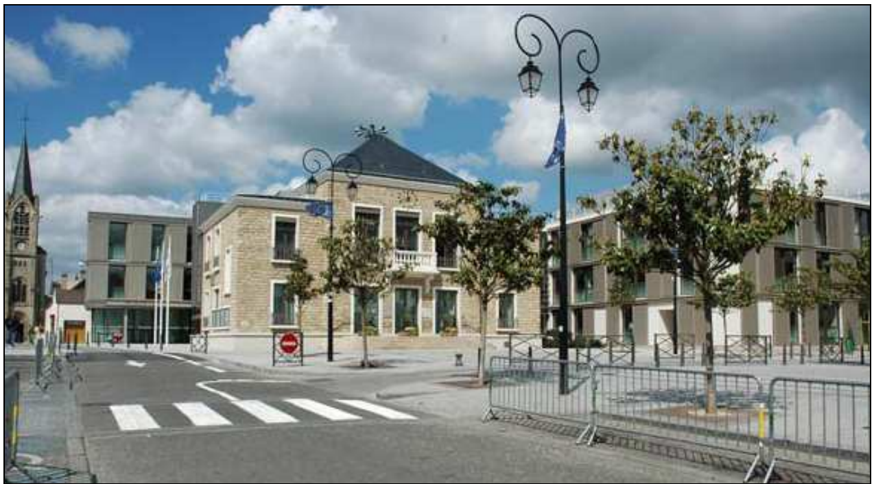
Illustration 77 : Mairie des Mureaux, façade sur la place de la Libération.
