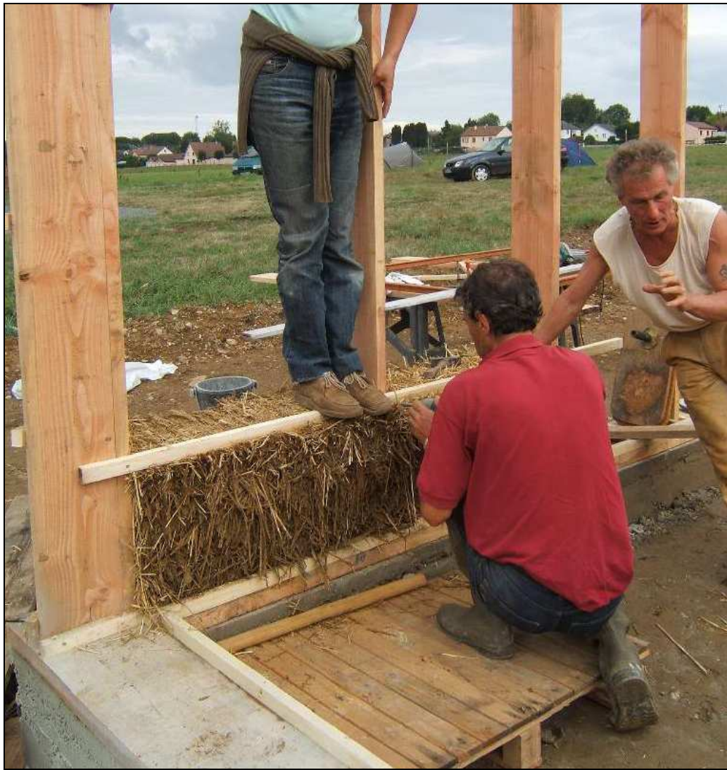
Illustration 165 : Technique C.S.T., mise sous tension avant fixation définitive.
