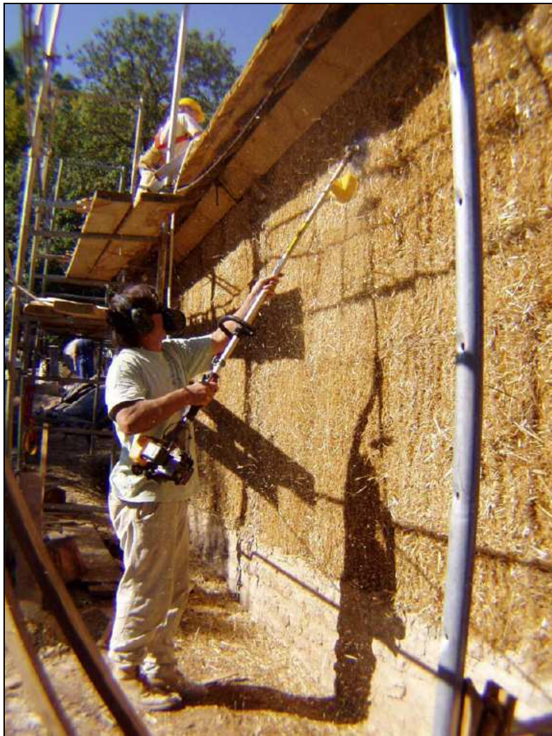
Illustration 161 : Salle de réunion du plan d'eau du Lambon, dressage des murs.
