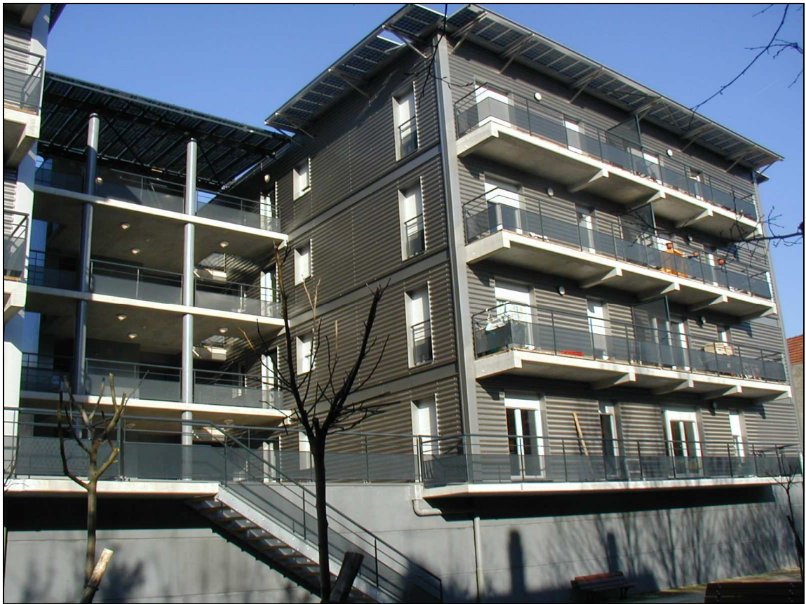
Illustration 116 : Immeuble 31-33 rue Moyrand, façade sud, sur jardin.
