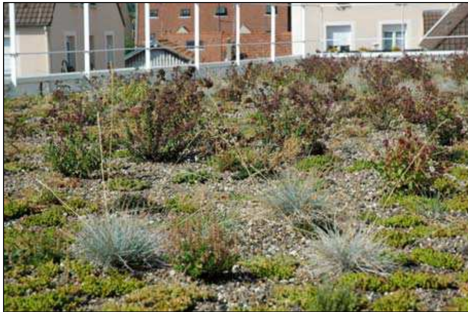
Illustration 84 : Mairie des Mureaux, toiture végétalisée.
