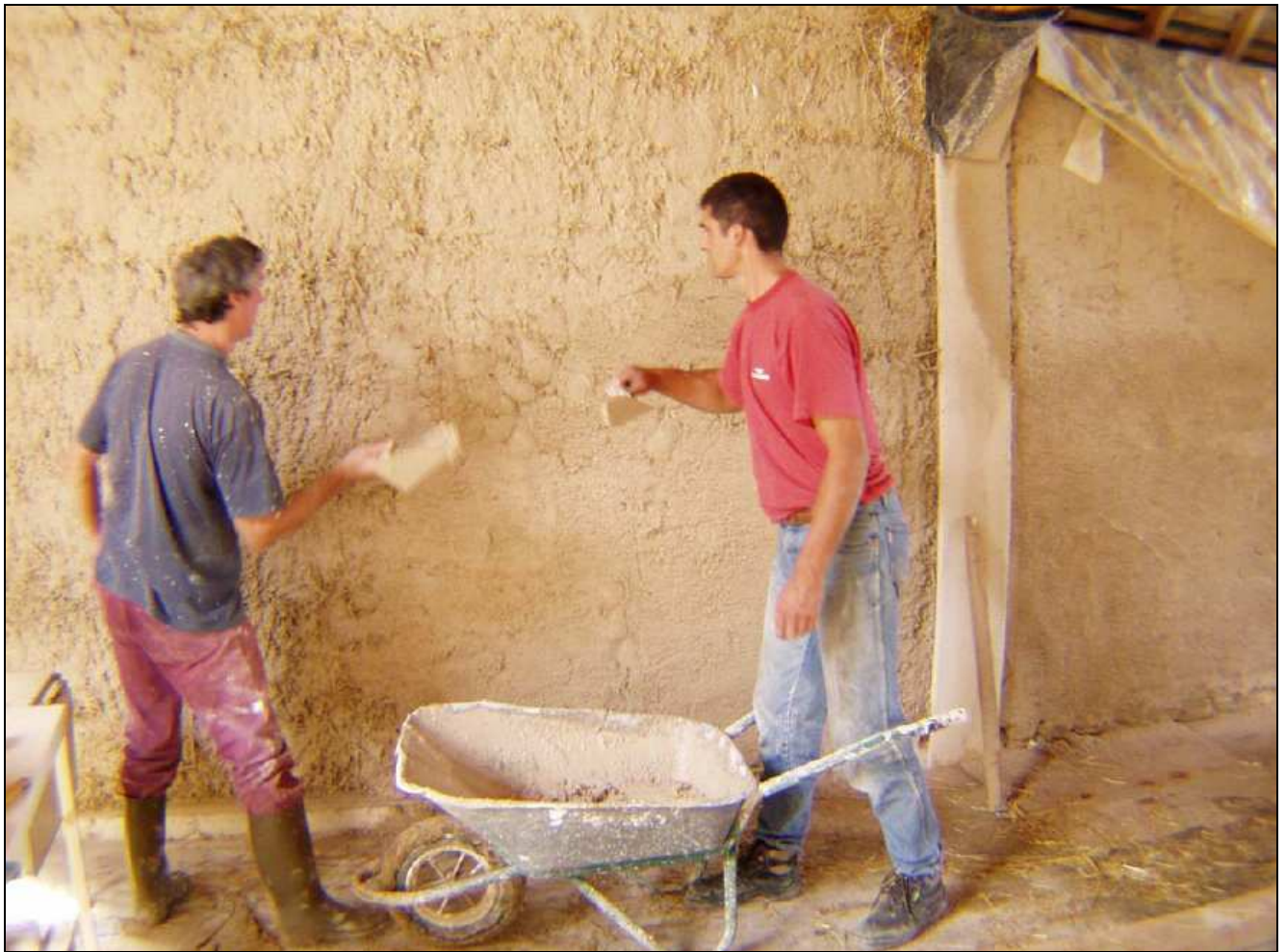
Illustration 163 : Salle de réunion du plan d'eau du Lambon, couche d'enduit de finition.
