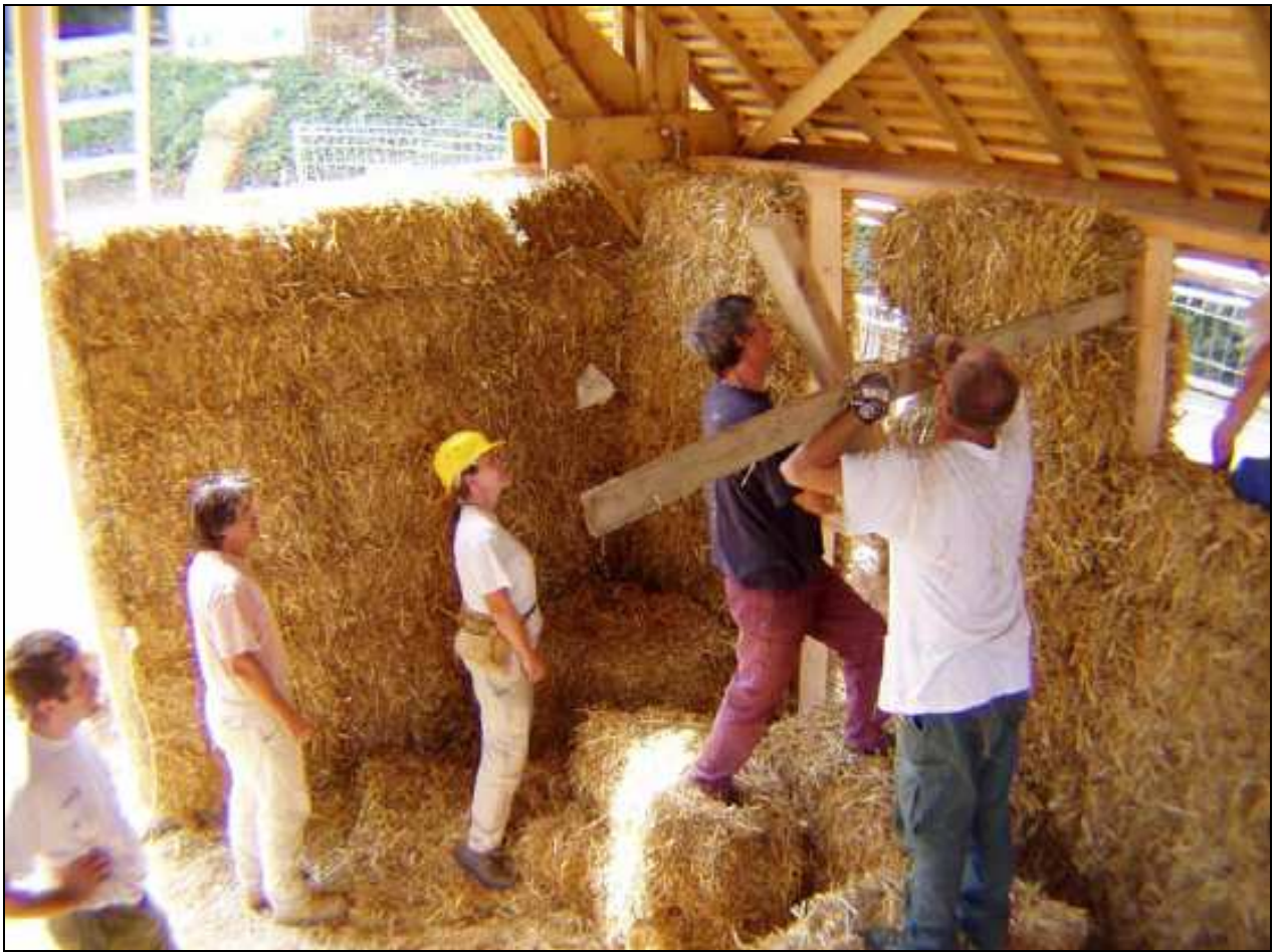
Illustration 159 : Salle de réunion du plan d'eau du Lambon, remplissage des murs.
