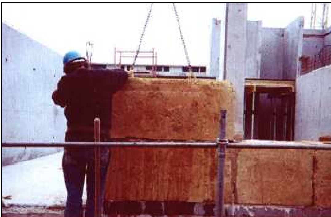
Illustration 126 : chantier de la résidence Salvatierra, mise en place des blocs de bauge.
