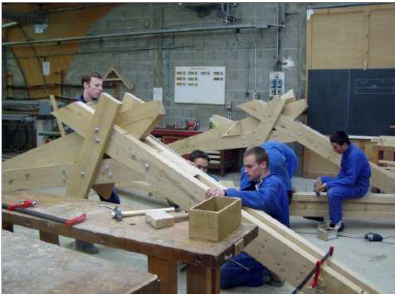
Illustration 157 : Salle de réunion du plan d'eau du Lambon, réalistaion de la structure dans un lycée technique.
