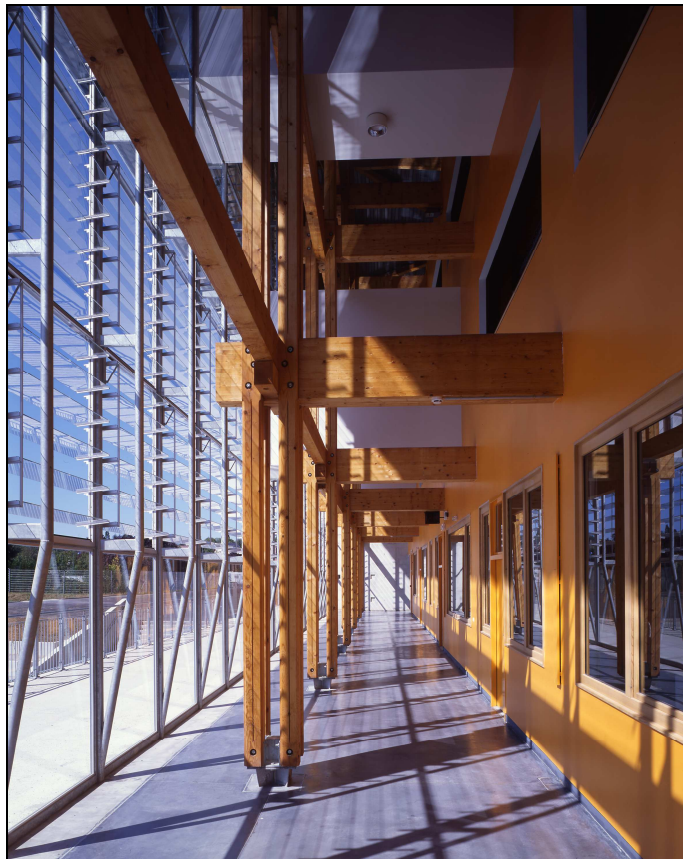
Illustration 76 : Collège Guy Dolmaire, espace tampon du rez-de-chaussée et vue sur les ventelles.
