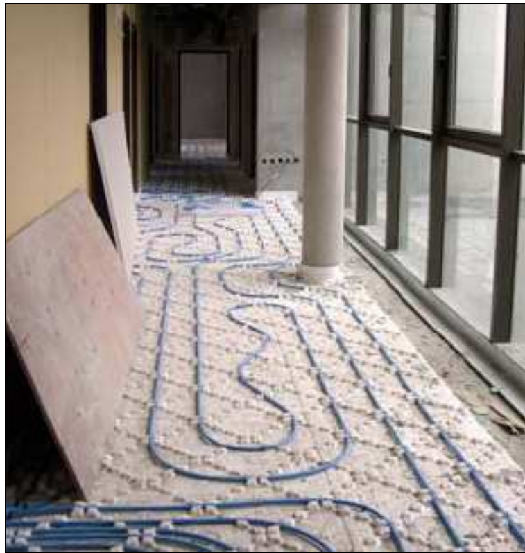
Illustration 91 : Mairie des Mureaux, installation du plancher chauffant.
