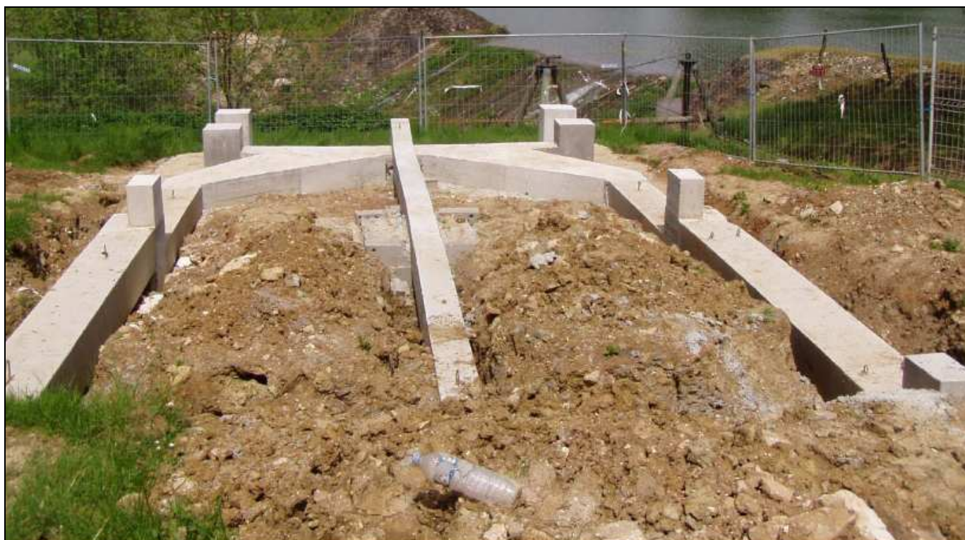
Illustration 156 : Salle de réunion du plan d'eau du Lambon, semelle de fondation.
