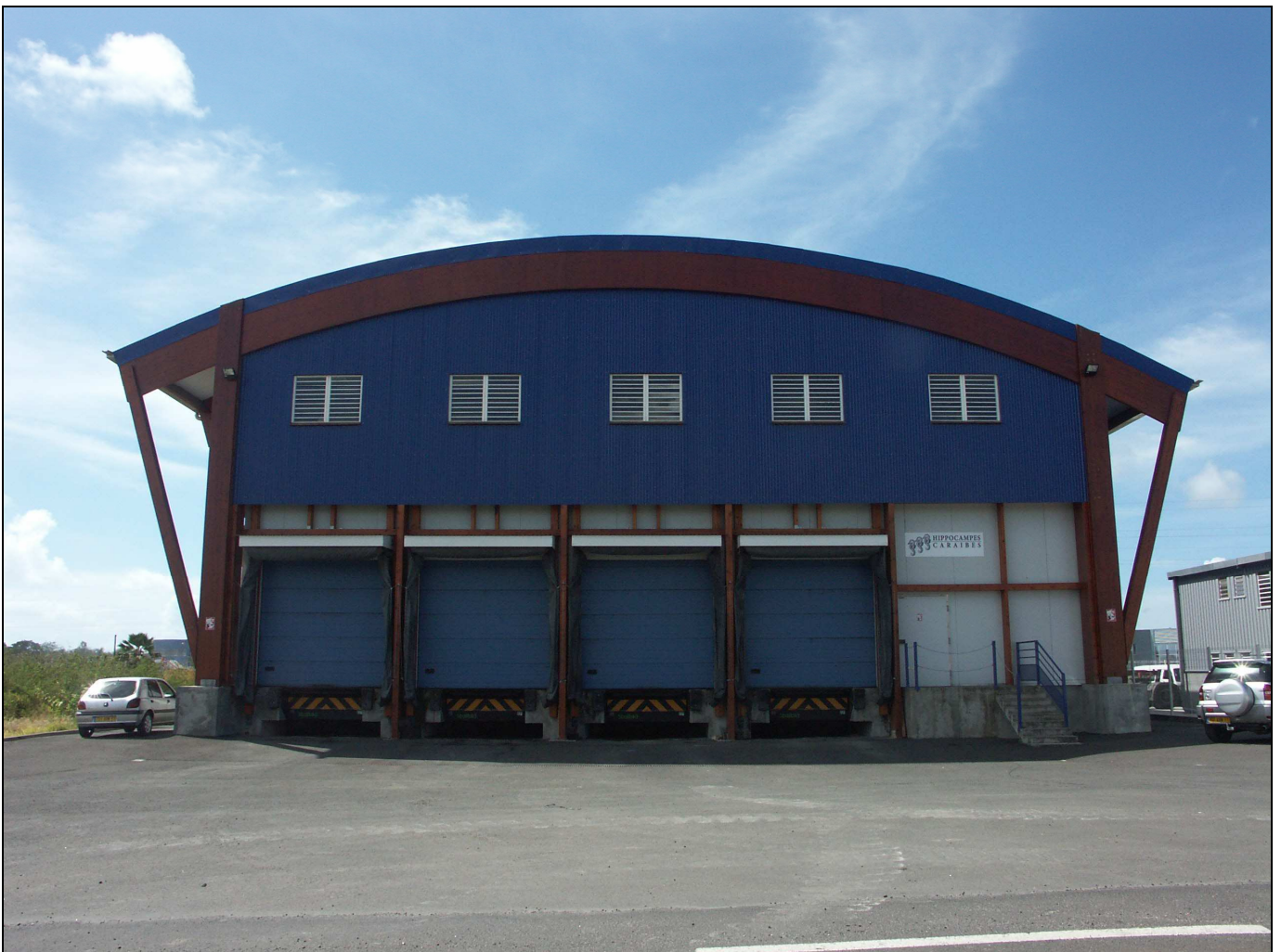
Illustration 104 : Chambre froide Hippocampe caraïbe, façade nord.
