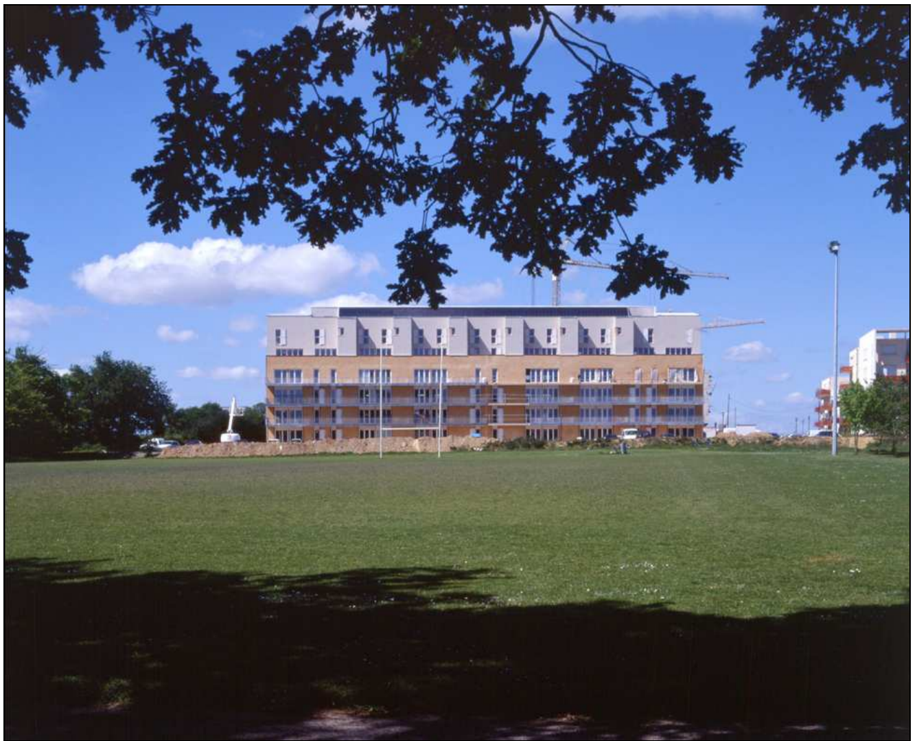
Illustration 119 : Résidence Salvatierra, façade sud.
