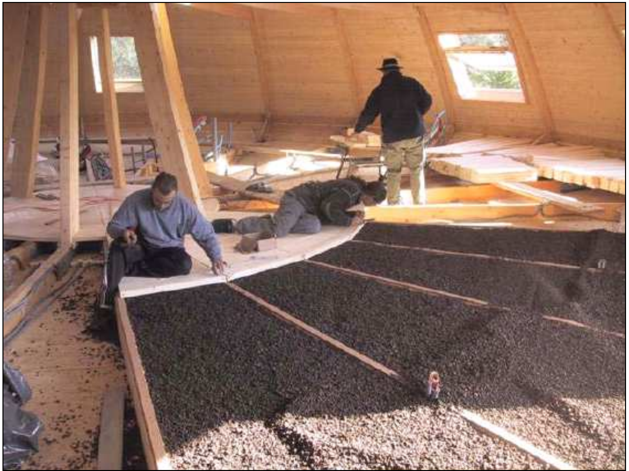
Illustration 141 : Isolation liège du plancher d'un Domespace.
