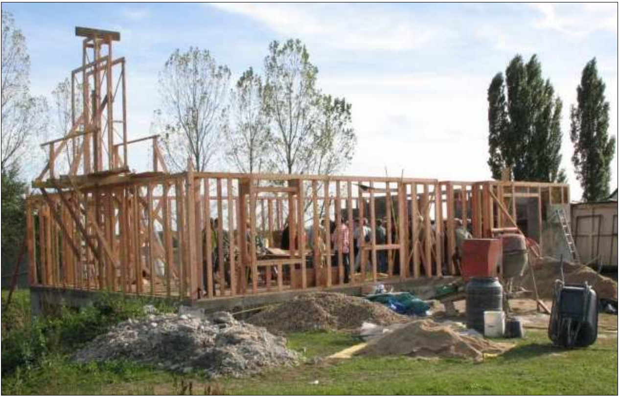
Illustration 153 : Technique du G.R.E.B., structure porteuse.
